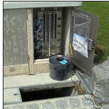
Telefonverteilerkasten
